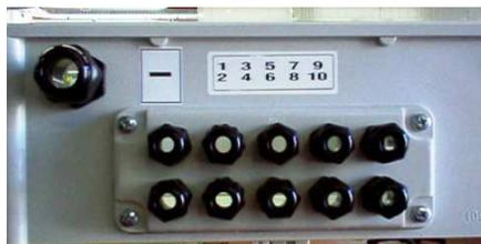
**Figura 9-20: Pressacavo per il collegamento delle stringhe negative**
