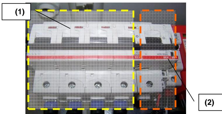
**Figura 6-6: Interruttore Sezionatore DC (1), componente per lo sgancio remoto e contatto ausiliario di stato (2).**
