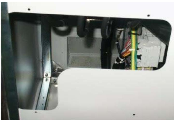
Figura 11-3 : Apertura passaggio cavi DC tra Framework – vista da sotto.
