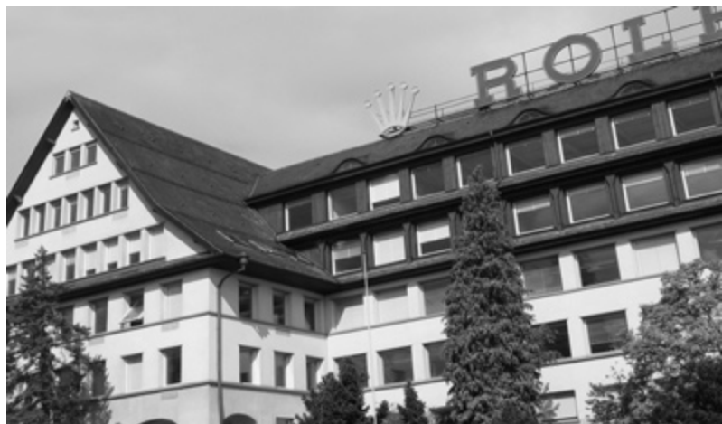
Sede centrale della Sputnik Engineering AG in quello che era lo stabile della Rolex, nella metropoli orologiera di Bienne, Svizzera.
