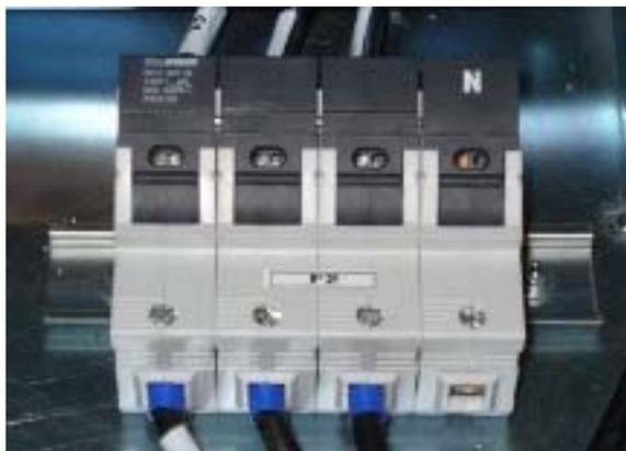
**Figura 15-10- Portafusibili F2 per protezione OVR AC**
