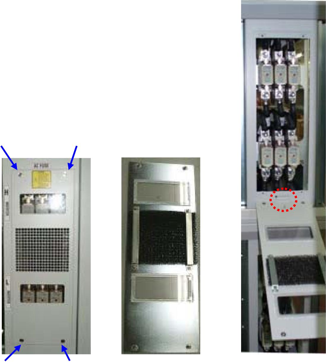
Figura 15-6- Filtro “Zona fusibili AC” (esterno ed interno del pannello)
