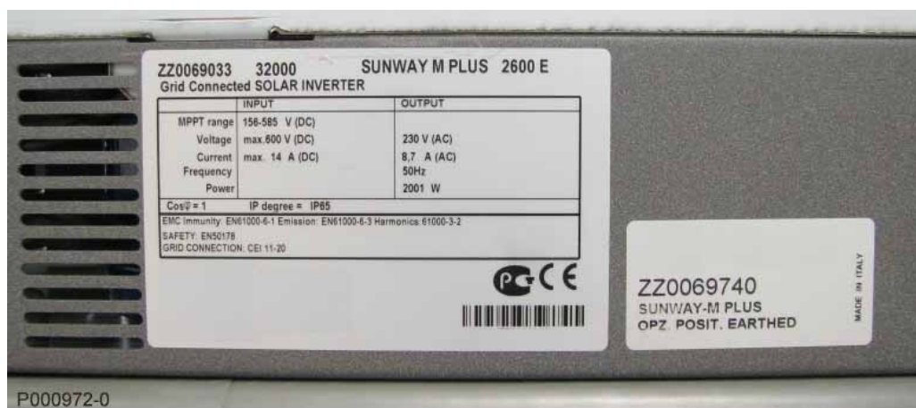
Figura 6: Etichette apposte sull'inverter
