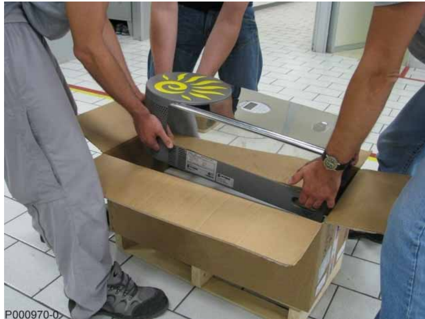
Figura 9: Estrazione dell'inverter dall'imballo
