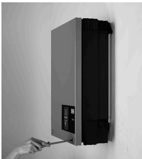
Per allentare le due viti anteriori utilizzare un cacciavite TX 30. Girare il cacciavite fino a quando si sente che le viti stanno per uscire dalla sede. Sono dotate di una molla che ne impedisce la caduta.
